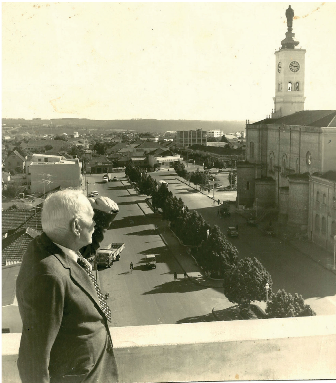
Elidio Stabile observa Catedral Nossa Senhora de Lourdes do alto do Edifício Stabile em construção
