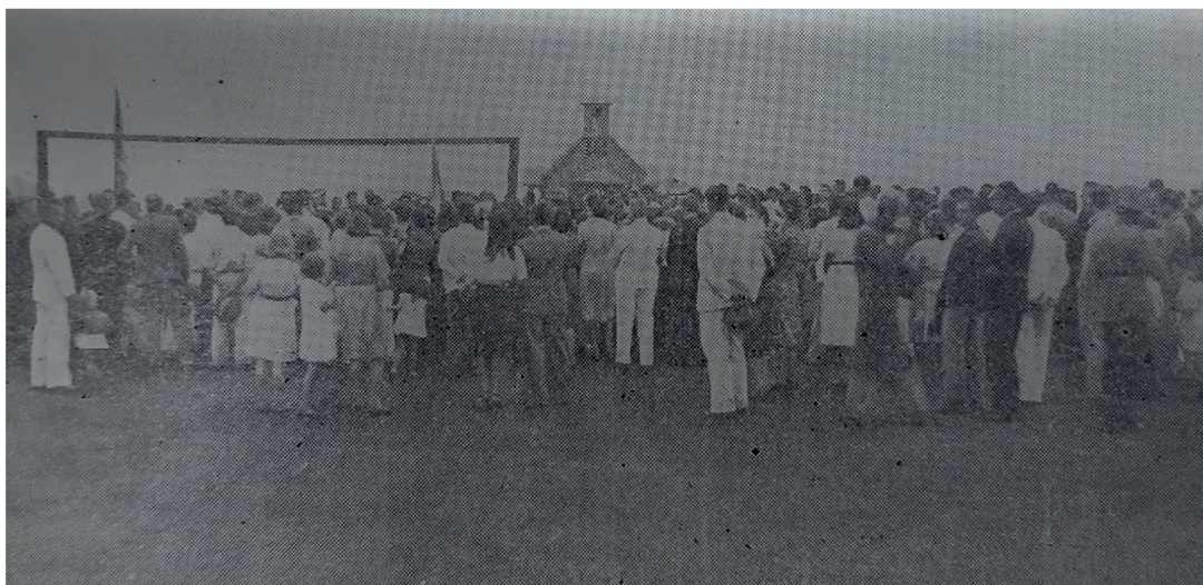
Gol "emoldura" ao fundo a igrejinha de madeira; foto é da inauguração da segunda capela em 1942 - a primeira foi derrubada pelo vento no ano anterior
