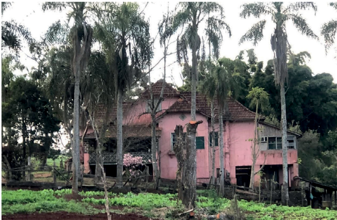
Construída por volta de 1940, sede da Fazenda Santo Ângelo ainda permanece em pé na região do Parque da Raposa
