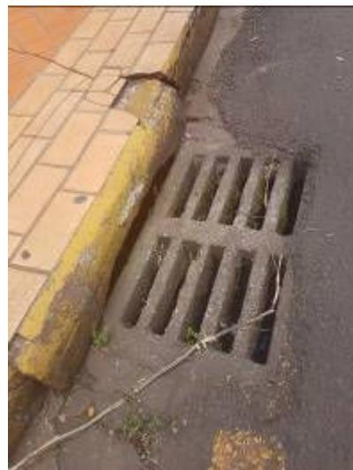
**Boca de Lobo – (grelha de concreto armado)**
