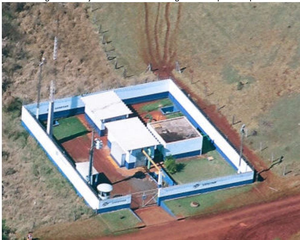
Figura 08 - Poço Tubular Profundo a região do Parque da Raposa
