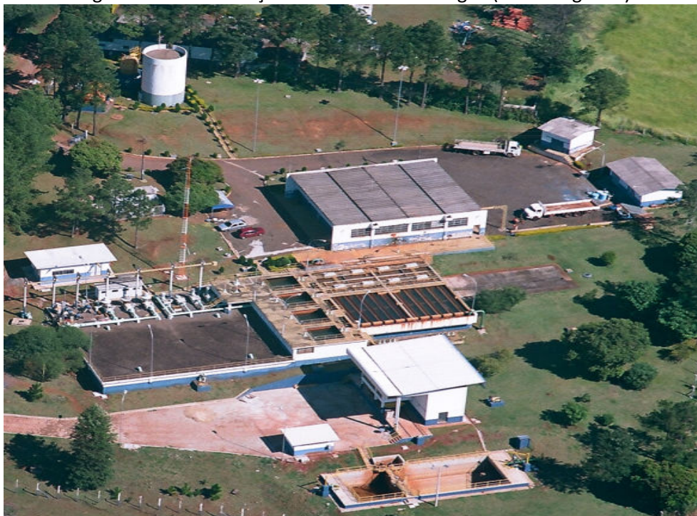
Figura 09 - ETA – Estação de Tratamento de Água (Jardim Figueira)
