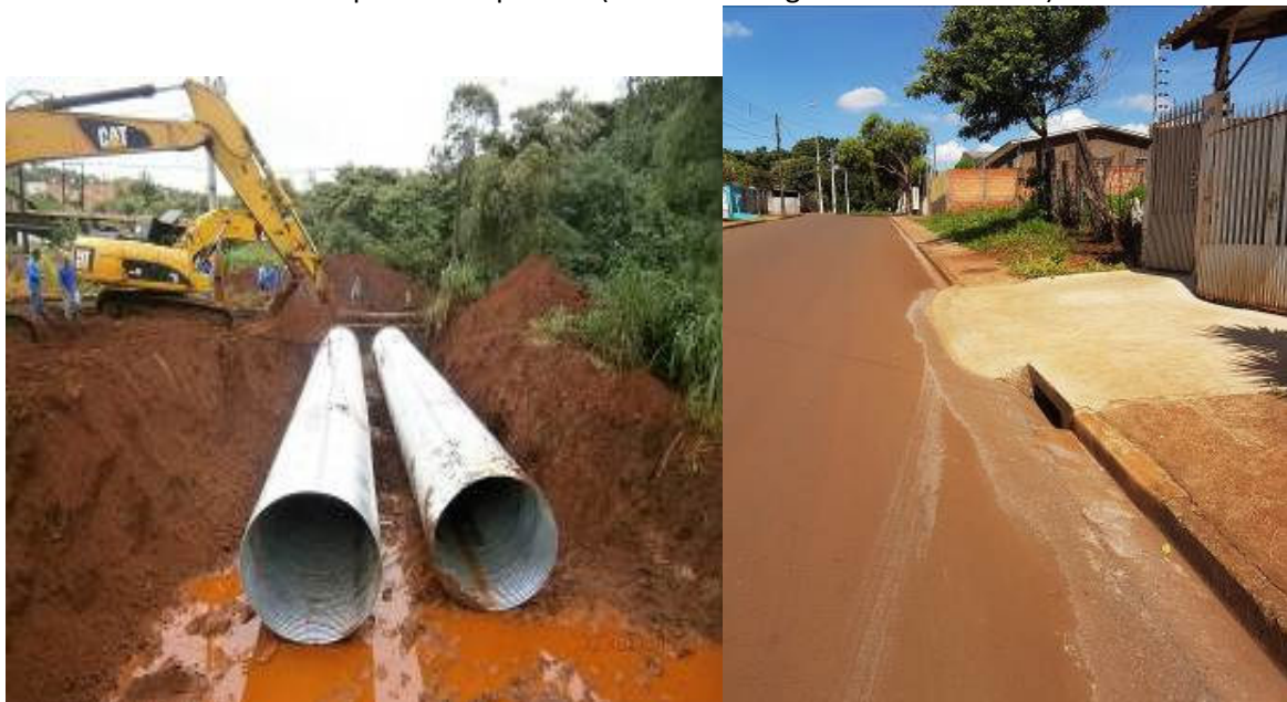
Figura 33 – Vista do processo construtivo de bueiros na Rua Cristiano Kusmaull e vista da construção de uma rampa sobre o passeio (desviando a água da boca de lobo).
