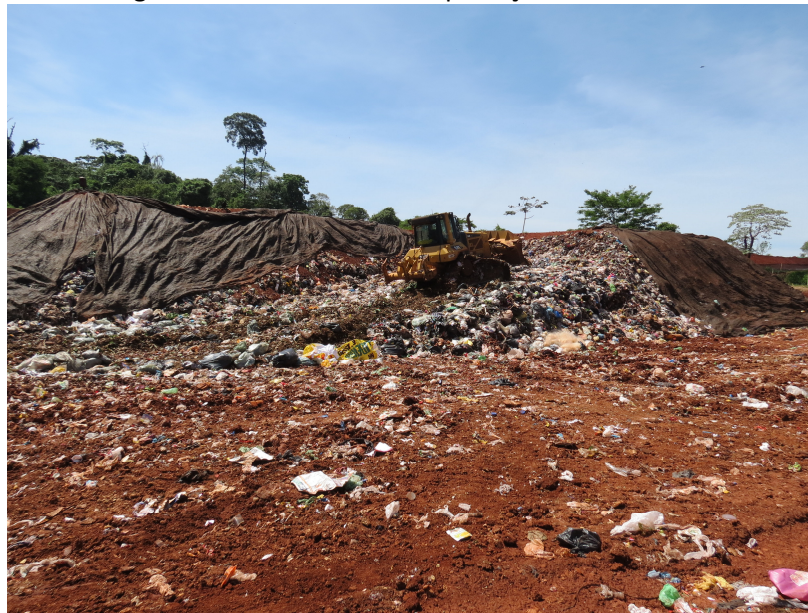
Figura 22 – Trabalho de compactação dos resíduos.
