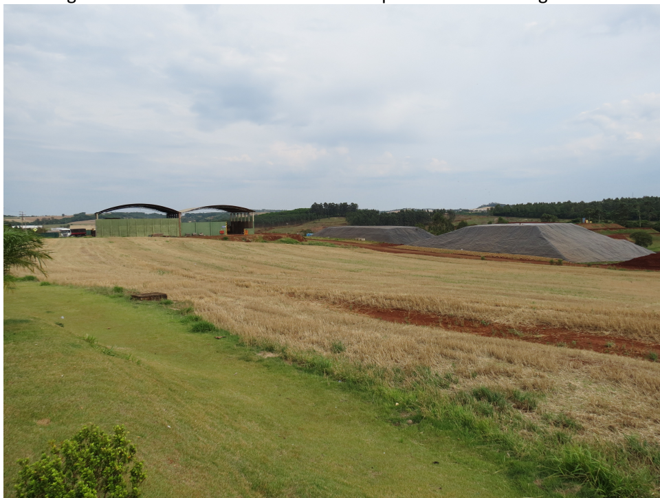
Figura 31 – Vista geral do aterro industrial administrado pela Terra Norte Engenharia Ambiental Ltda.
