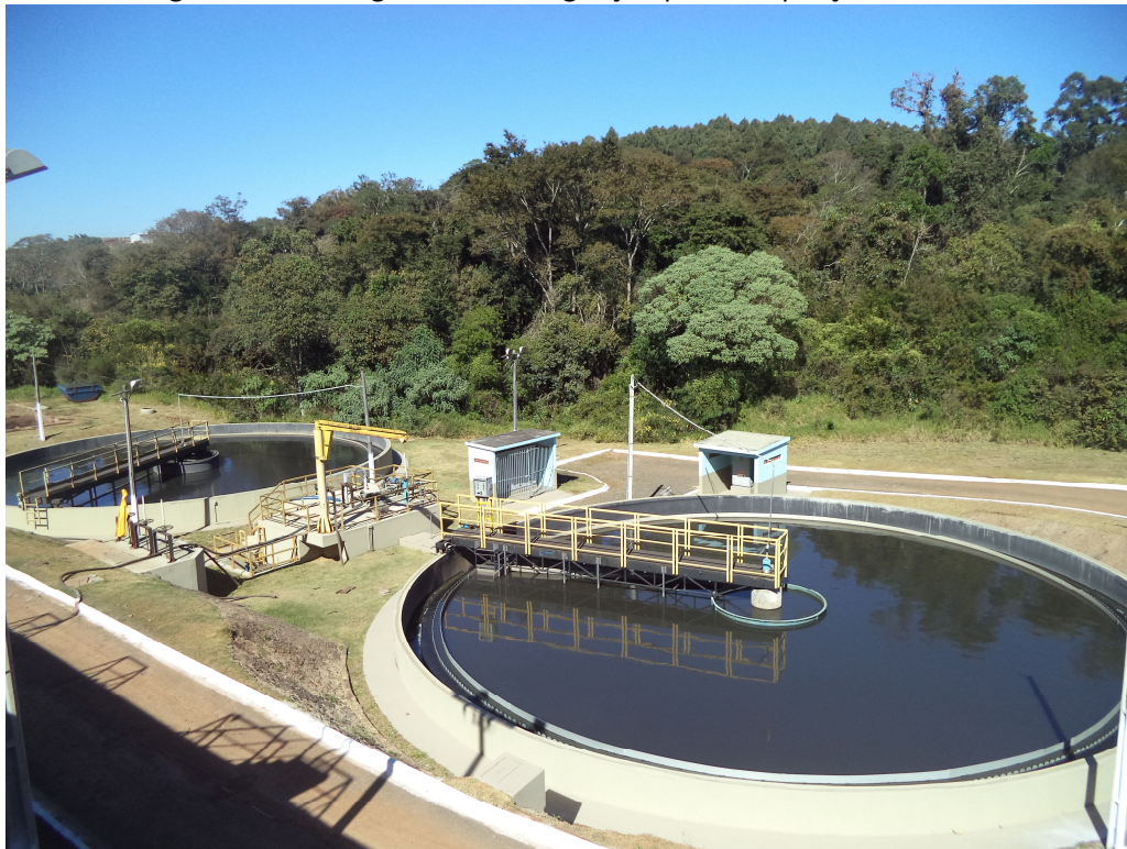
Figura 12 – Vista geral da ETE Biguaçu após a ampliação de 2015.
