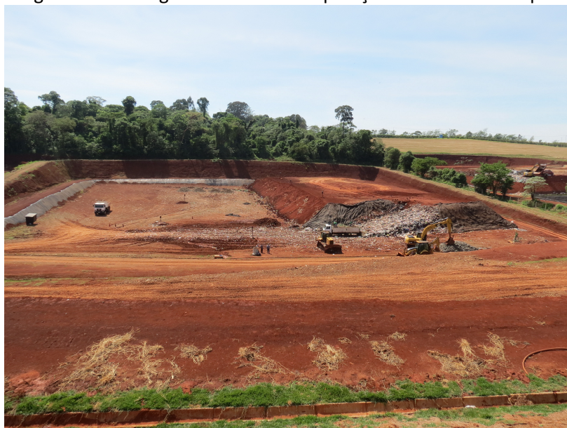
Figura 19 – Vista geral da célula em operação no aterro municipal.
