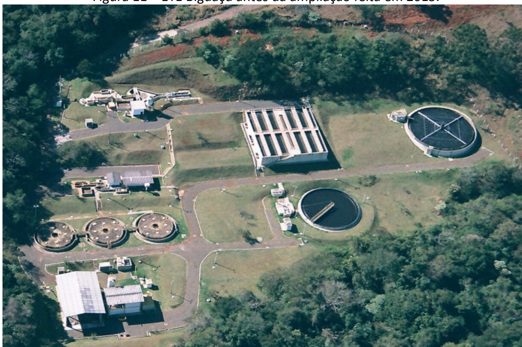
Figura 11 – ETE Biguaçu antes da ampliação feita em 2015.
