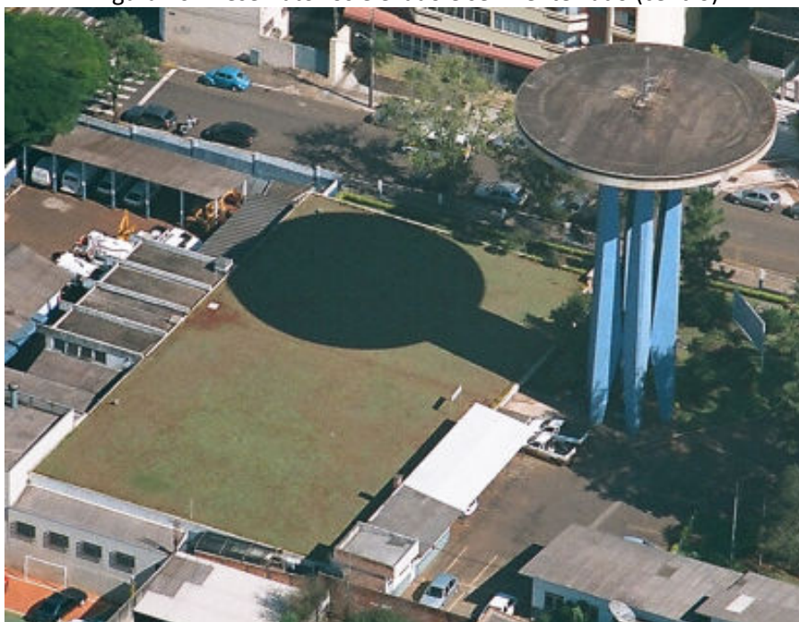
Figura 10 - Reservatórios elevado e semi-enterrado (centro)
