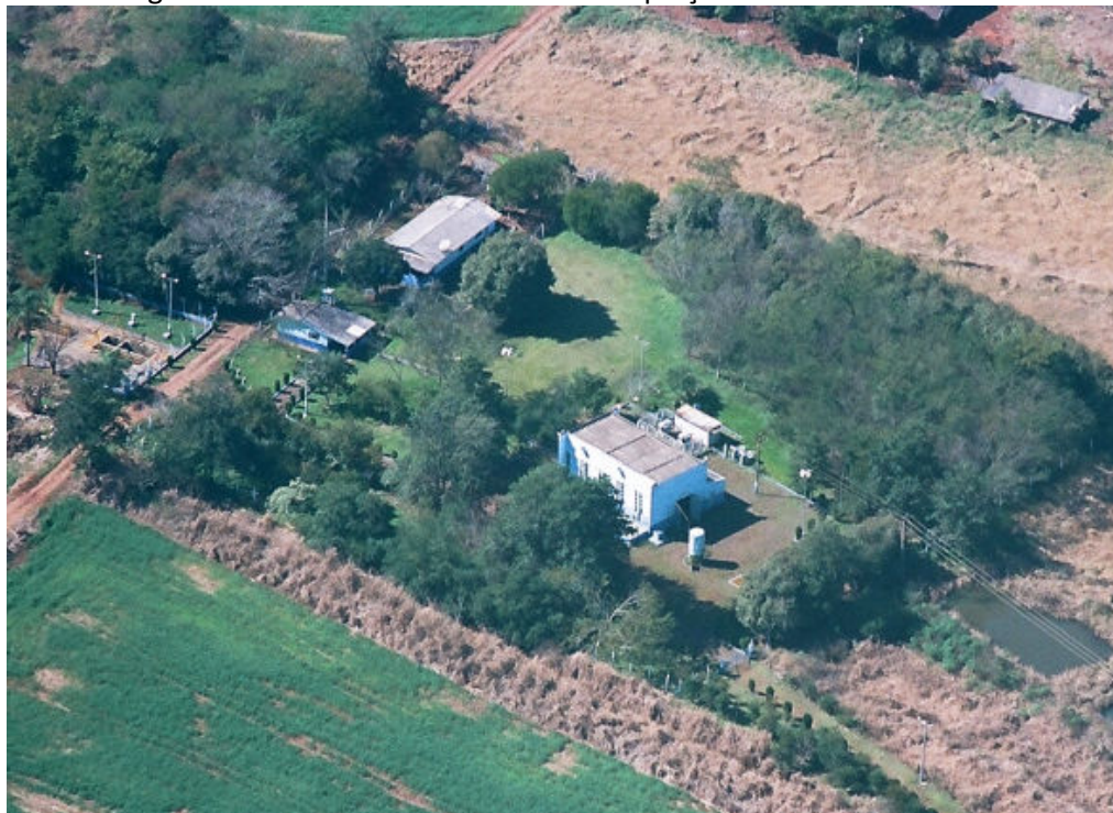
Figura 07 - Vista aérea da Unidade de Captação no Ribeirão Caviúna.
