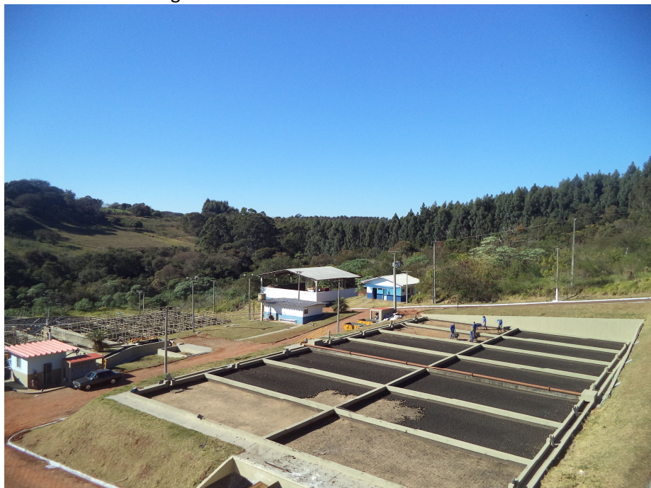
Figura 14 – Visão local da ETE Barra Nova
